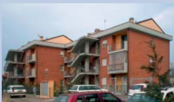
Villanova, Regione Stazione lotti 1 2 (28 alloggi)
